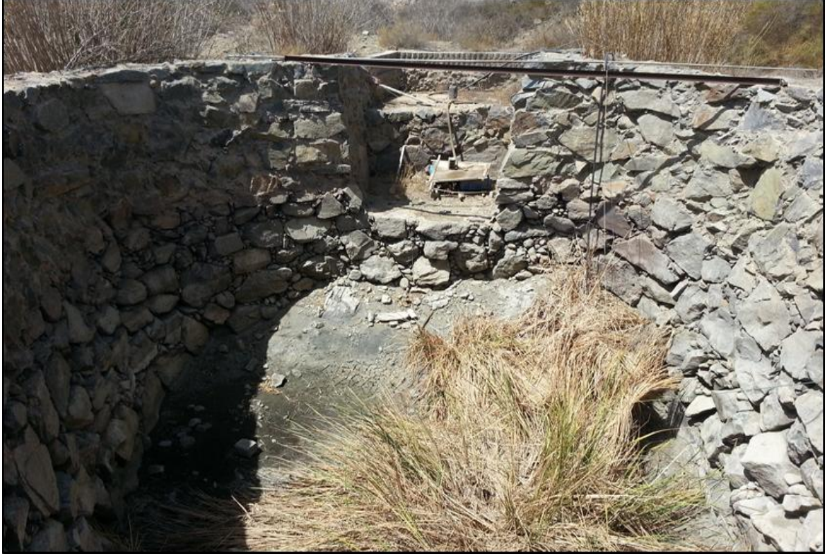
صورة رقم (2) بئر سطحية جافة في منطقة الدراسة- المصدر/ الباحثين- تصوير ميداني - ضمن منطقة وادي بيشة
